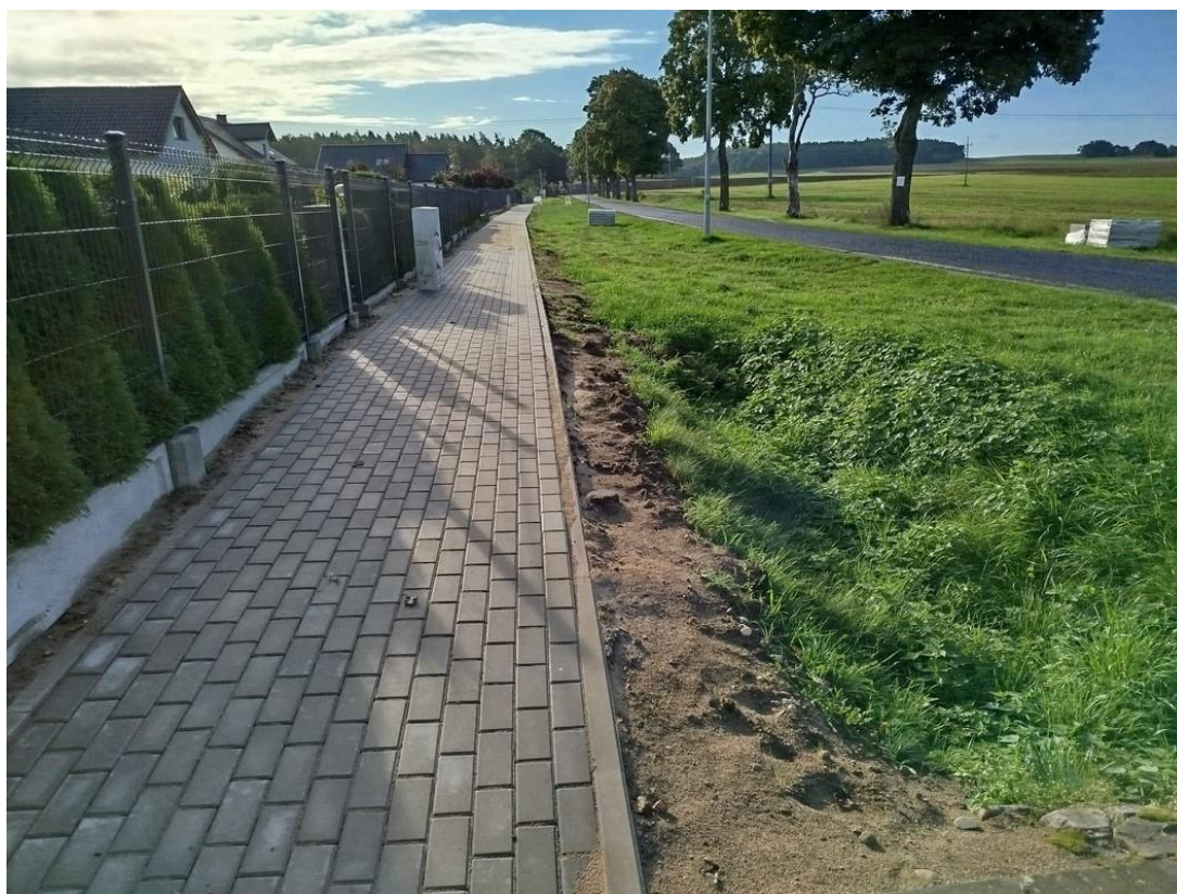
Budowa chodnika w m. Kluczkowo w ciągu drogi powiatowej 1082Z
