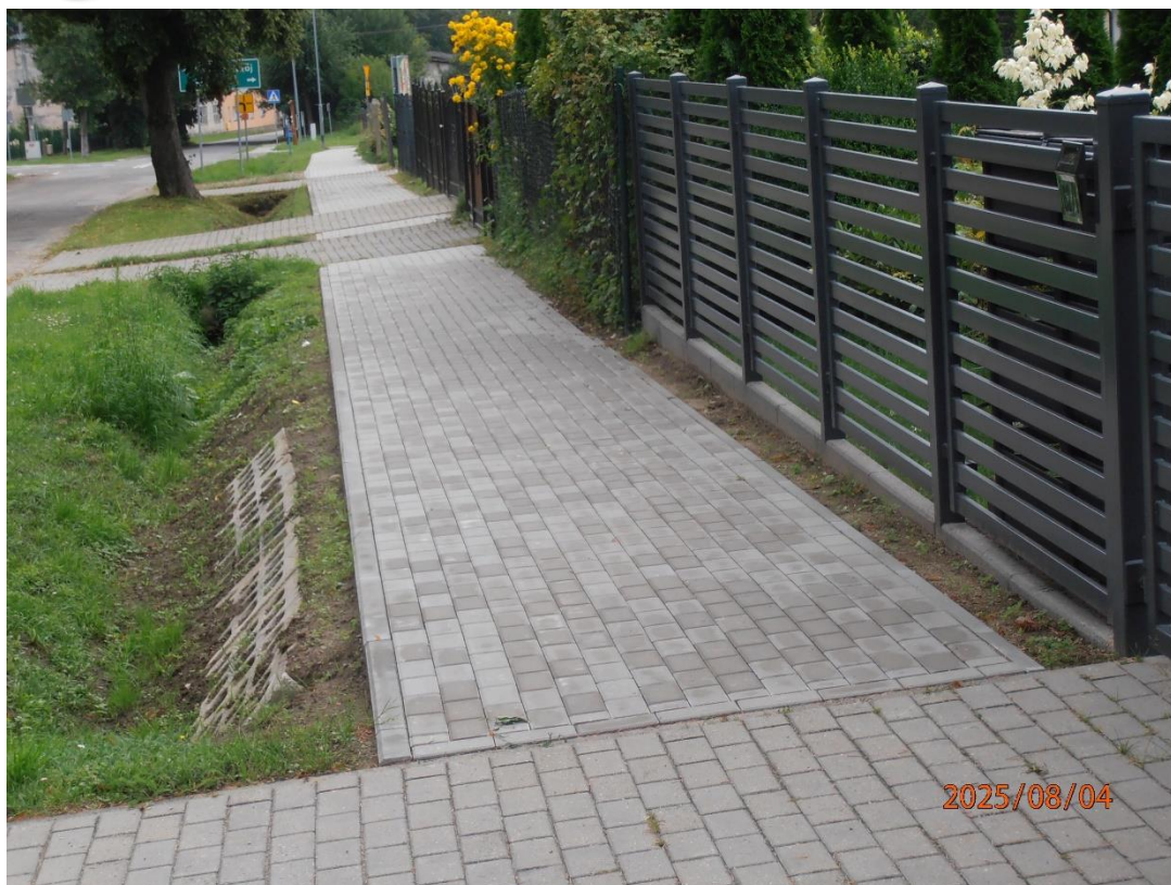
Budowa chodnika w m. Rąbino w ciągu drogi powiatowej nr 1058Z
