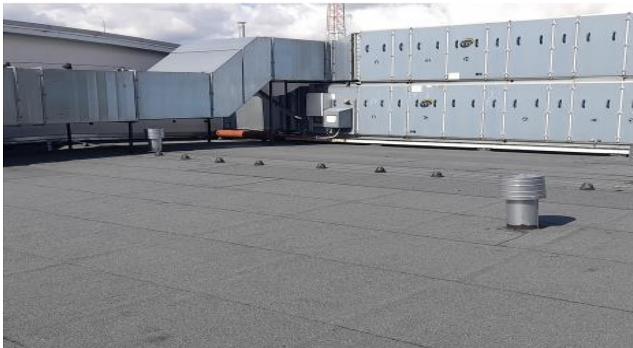
Wyremontowany dach łącznika budynku szkoły z halą sportową Zespołu Szkół Rolniczych CKZ im. S. Żeromskiego w Świdwinie. Sierpień 2025 r.
