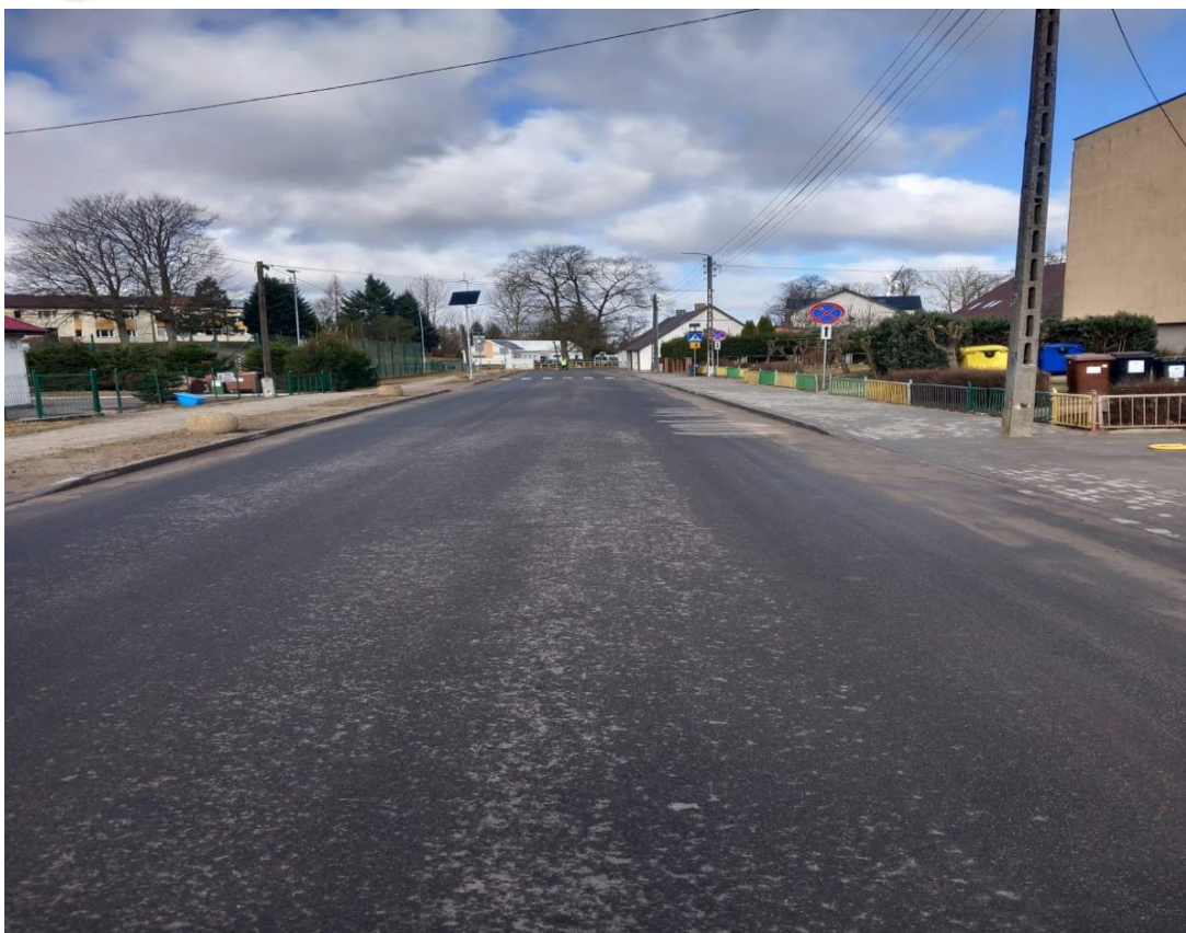
Remont drogi powiatowej Nr 1082Z na odcinku Kluczkowo – Bierzwnica
