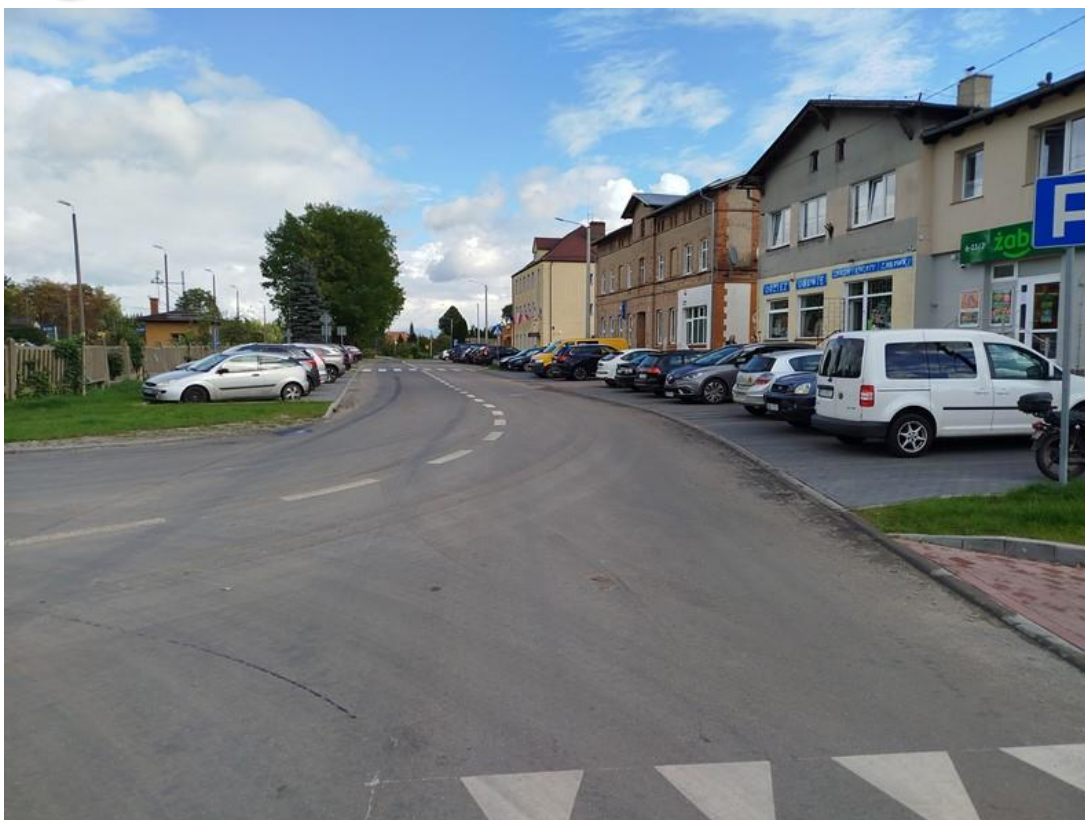
Przebudowa odcinków dróg powiatowych nr 1059Z i 1063 przez m. Rąbino wraz z budową kanalizacji deszczowej
