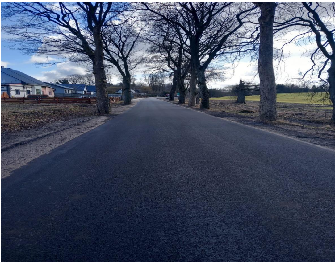
Remont drogi powiatowej Nr 1082Z na odcinku Kluczkowo – Bierzwica
