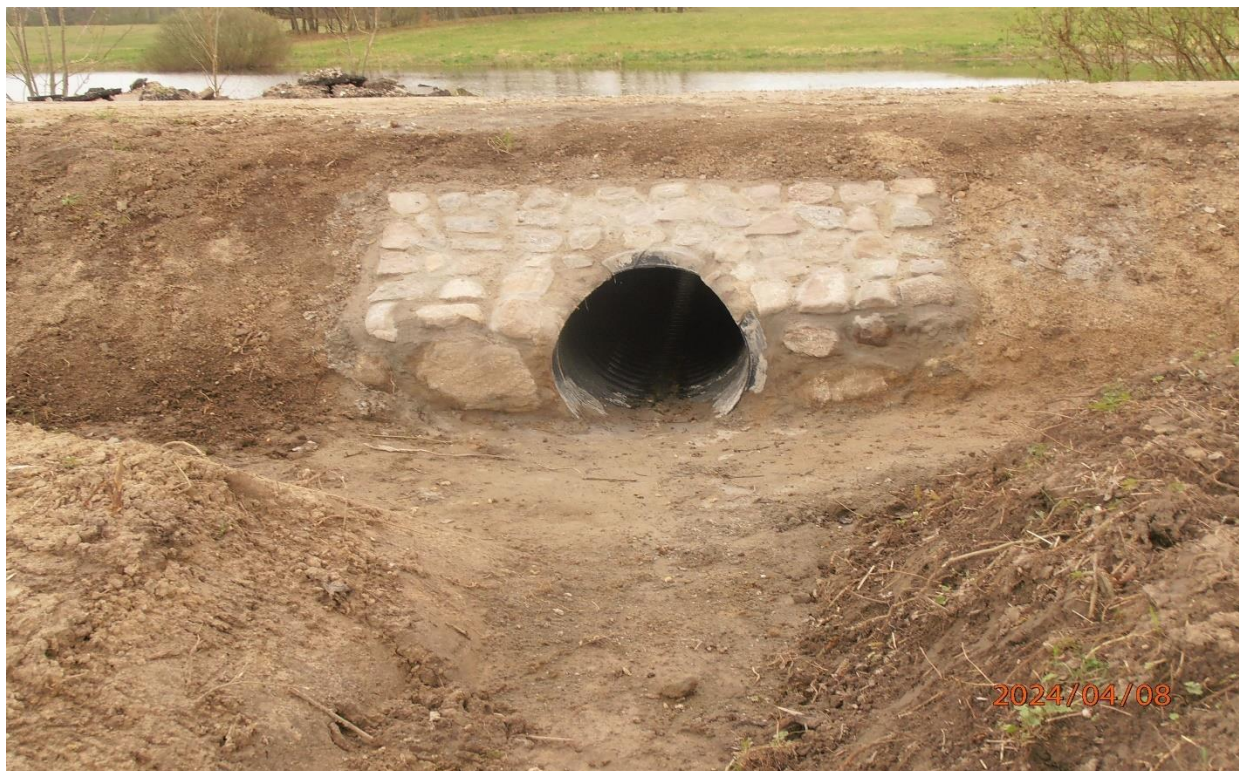
Wymiana dwóch przepustów w drodze powiatowej nr 1082Z na odcinku Stare Resko – Gawroniec
