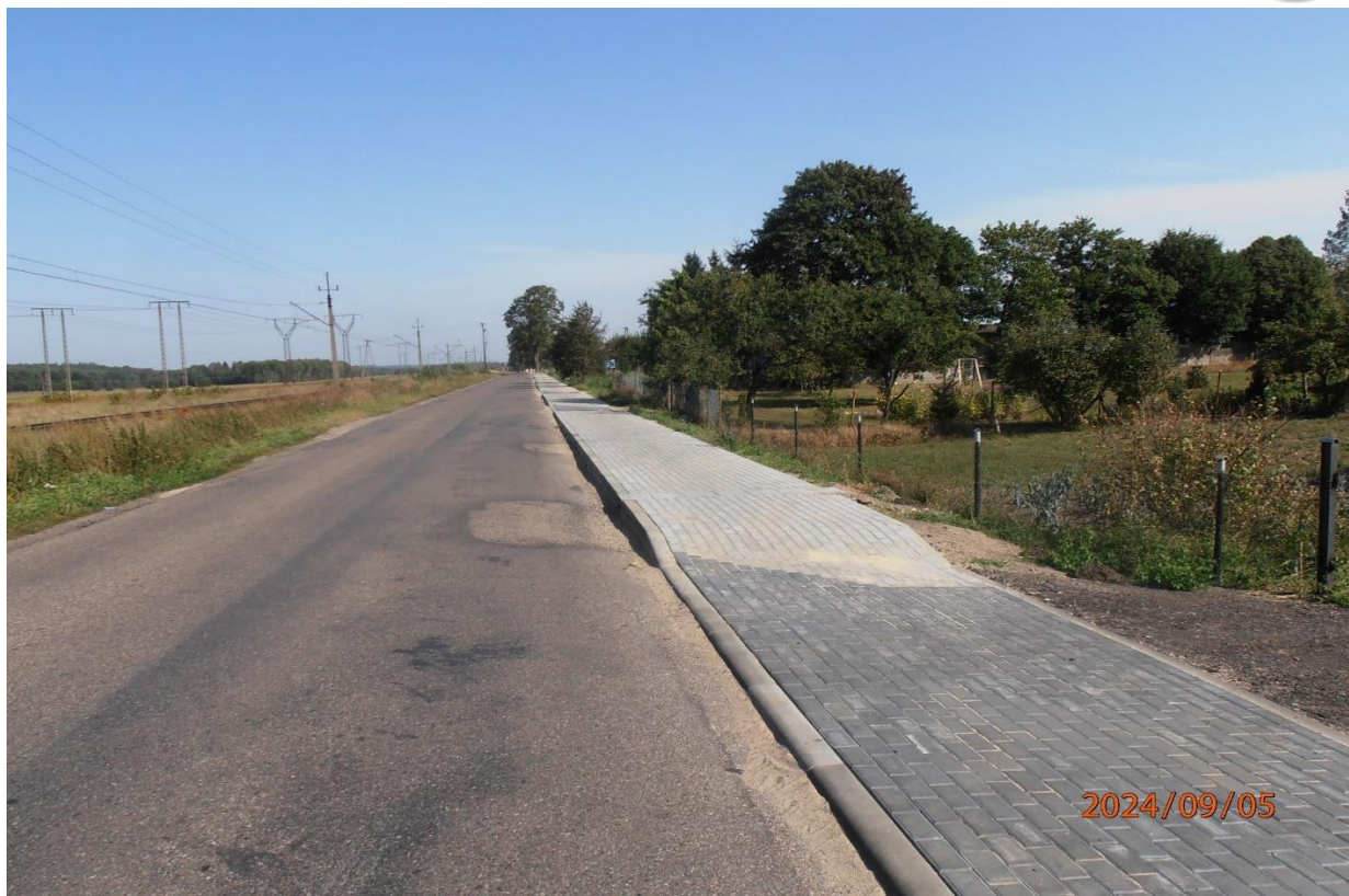
Budowa chodnika wraz z oświetleniem w ciągu drogi powiatowej nr 1074Z, ul. Spółdzielcza w m. Świdwin
