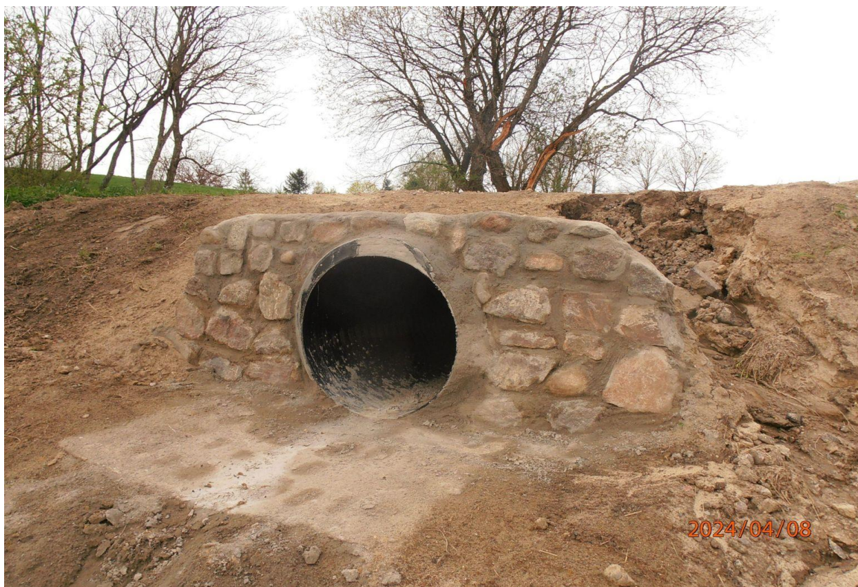
Wymiana dwóch przepustów w drodze powiatowej nr 1082Z na odcinku Stare Resko – Gawroniec
