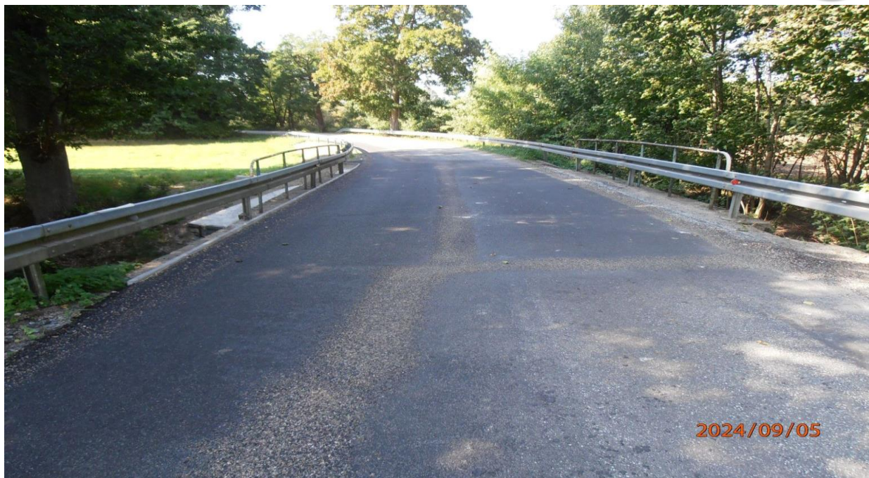
Remont elementów konstrukcyjnych nawierzchni nad przepustem w ciągu drogi Nr 1069Z obręb Łąkowo
