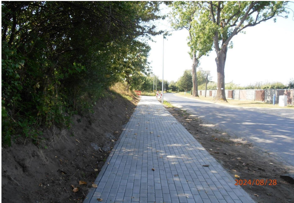
Przebudowa drogi powiatowej nr 1088Z w m. Połczyn Zdrój (ul. Powstańców Warszawskich) poprzez budowę chodnika
