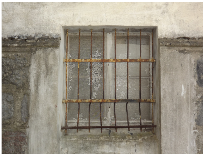
Zachowane okno historyczne
