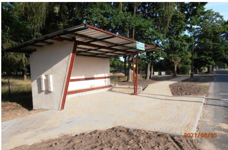
Przebudowa chodnika w miejscowości Cieszeniewo
