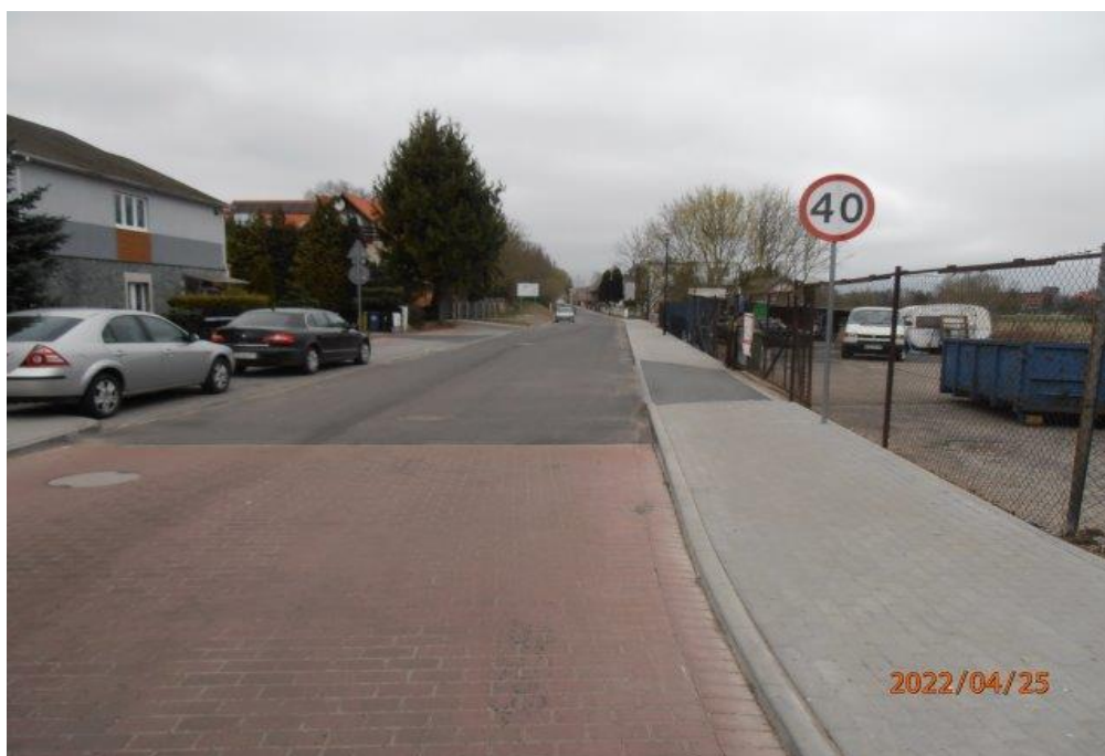
Przebudowa ul. Pocztowej w Świdwinie
