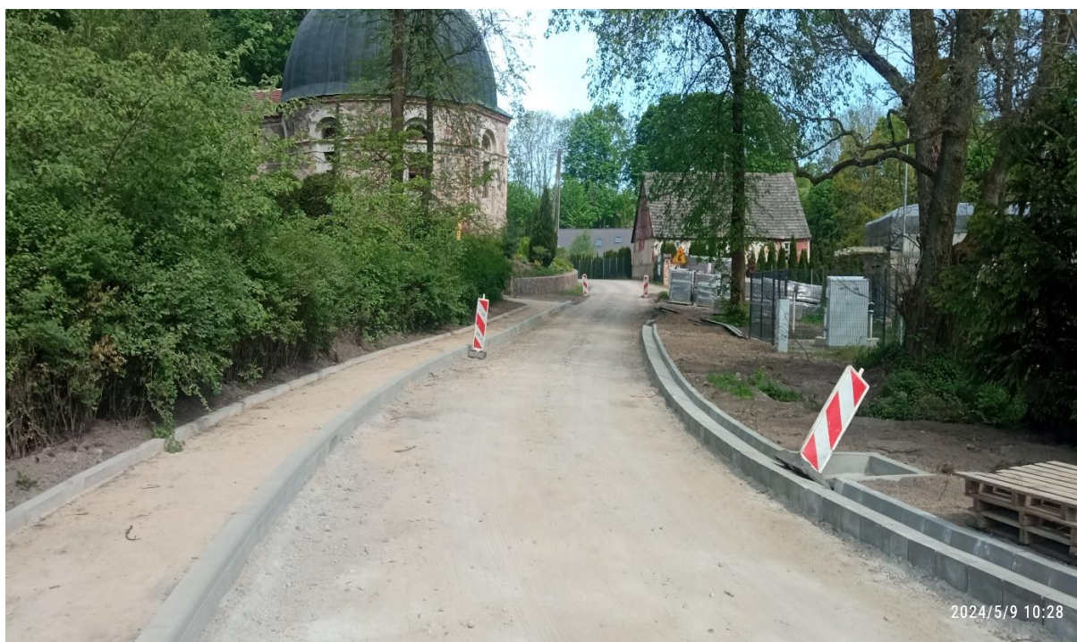
Remont nawierzchni drogi powiatowej Nr 1082Z na odcinku Stare Resko – Gawroniec
