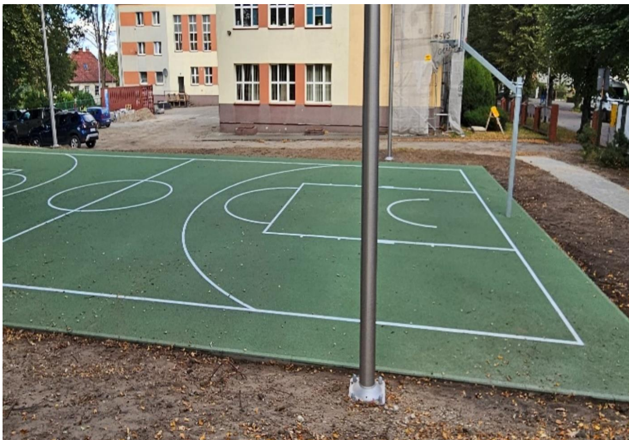
„Poprawa stanu przyszkolnej infrastruktury sportowej w Połczynie – Zdroju”,
