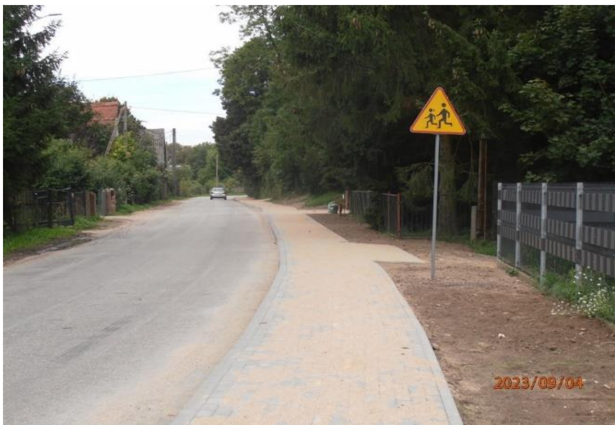
Remont chodnika wraz z budową zjazdów w miejscowości Przybysław
